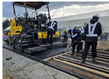
試験施工の様子
